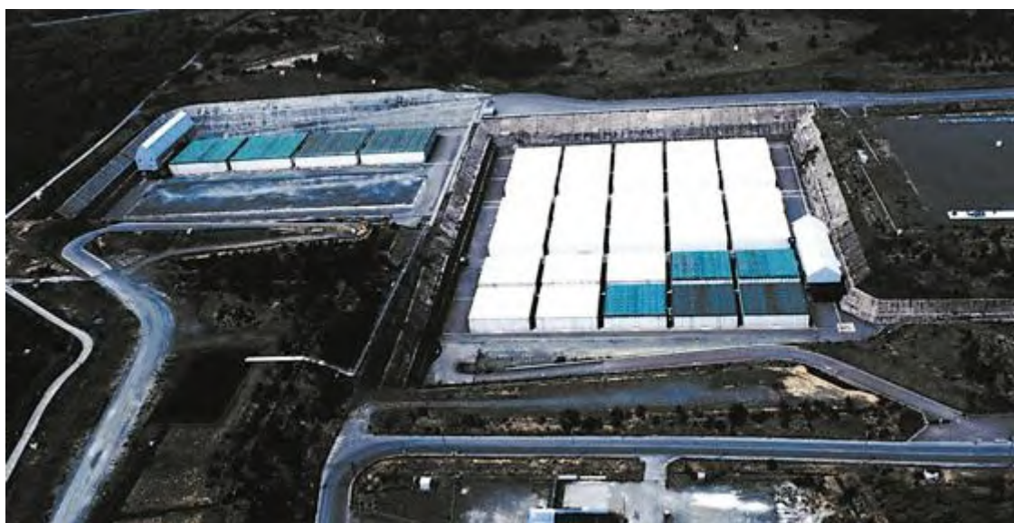
図 A12-2 日本原燃（株）低レベル放射性廃棄物埋設センター
