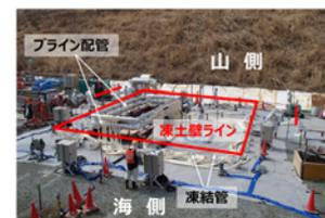
図 A14-5-(3) 凍土方式遮水壁大規模実証
